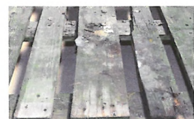
Trocknung/Reinigung durchnässter Bretter
